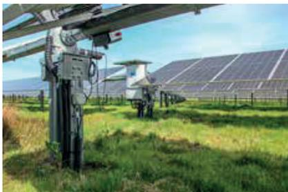
Ohne Fundament: Die verzinkten und mit Epoxidharz beschichteten Träger werden lediglich in den Boden gedrückt.
